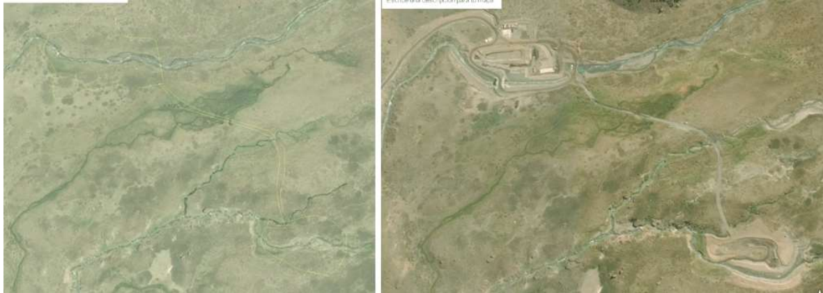
Figura N°15.1. Bocatomas estero La Engorda. Izquierda situación año 2013, derecha obras en febrero año 2017. (Fuente: Digital Globe. Google Earth).
