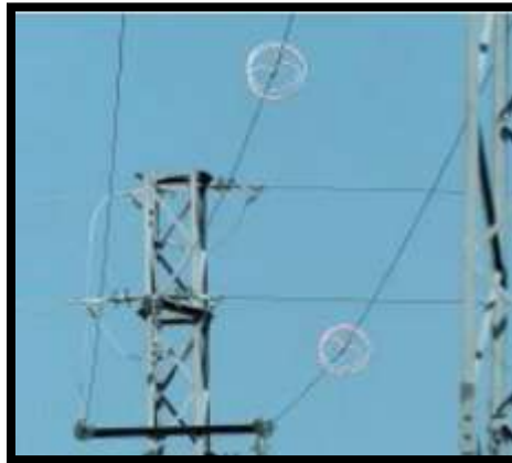
Figura 2. Dispositivo en tendido eléctrico que minimiza el impacto de las aves.
